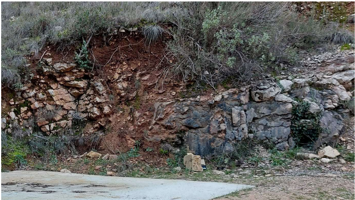
Figure 64. Perméabilité très élevée de fracture affectant les calcaires stratifiés du Jurassique supérieur
