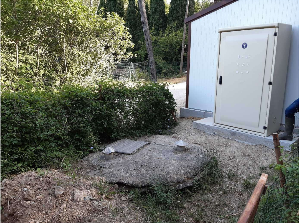
Figure 79. Tête béton de la bache dite de la Servie, à proximité immédiate du nouveau local technique
