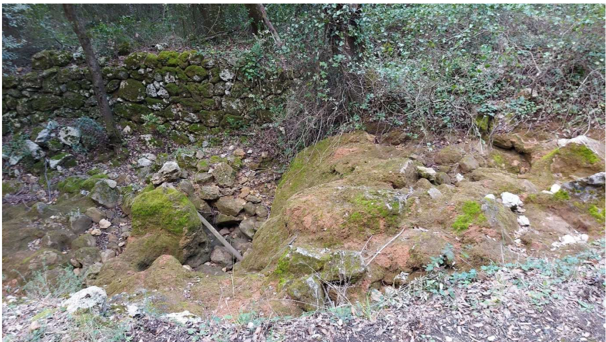
Figure 51. Tuffs développés aux dépens des calcaires du Trias moyen, recouvrant localement le fond du cours d'eau, et assurant une perméabilité poreuse
