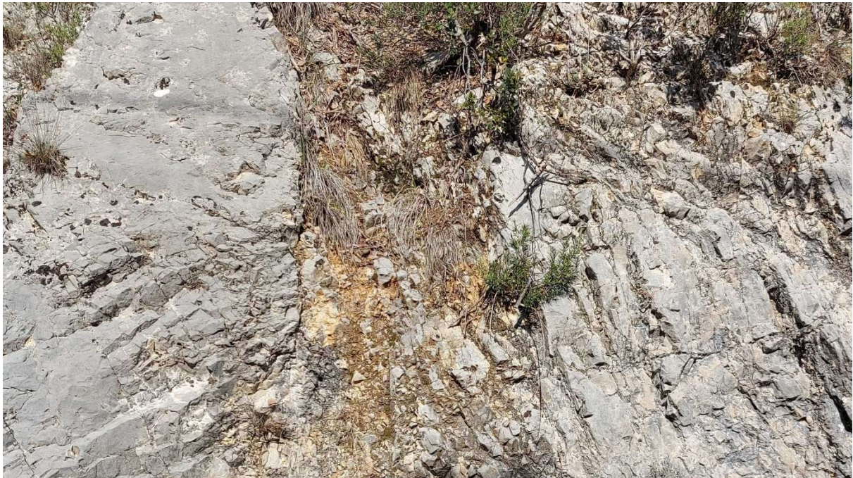
Figure 62. Perméabilité élevée le long d'une zone de faille affectant les calcaires le Trias moyen
