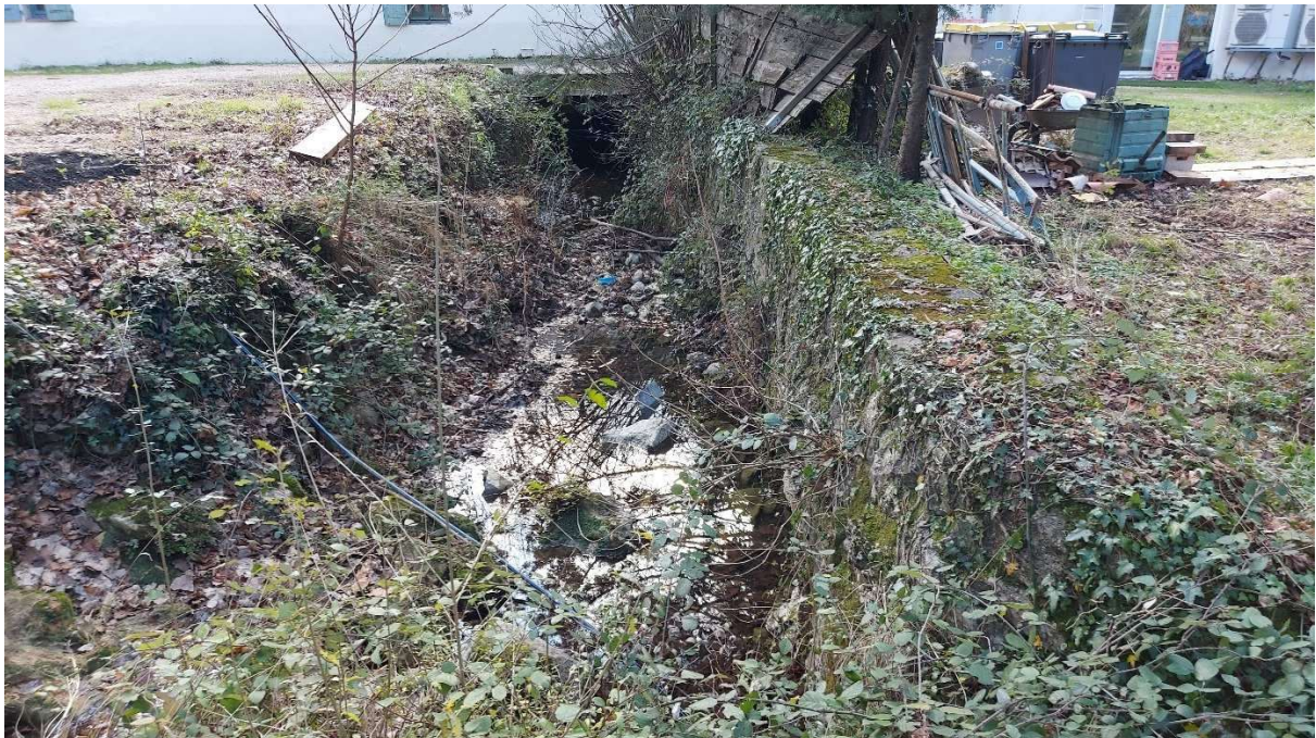
Figure 70. Cours d'eau de la Lone en amont du restaurant « La source », à l'aval immédiat de la zone d'émergence « Mère des Sources »
